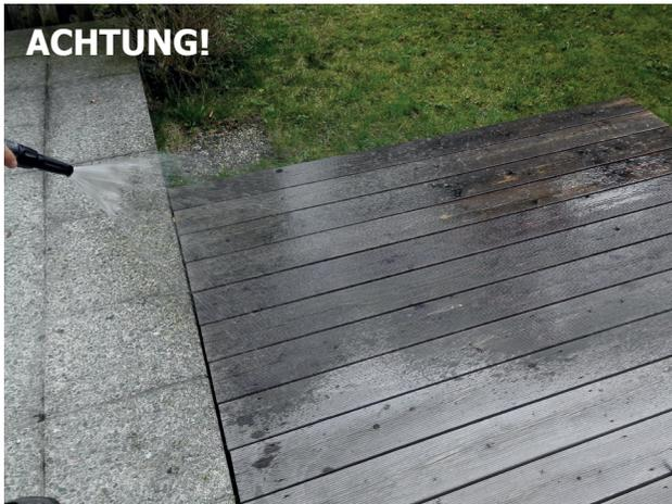
Der nahe liegende Weg, Terrassendielen aus Holz mit dem Hochdruckreiniger zu reinigen, ist nicht immer der beste. Durch das Auftreffen des scharfen Wasserstrahls kann es vor allem bei weichen Hölzern wie Lärche, Kiefer und Fichte zu Abtrennungen von Spänen kommen. Im Laufe der Zeit stellen sich die Holzfasern auf (das Holz frant aus) und verliert seine glatte Oberflächenstruktur.
